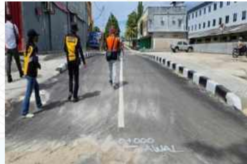
Rekontruksi/ Peningkatan Jalan Selat Bali – Distrik Biak Kota
