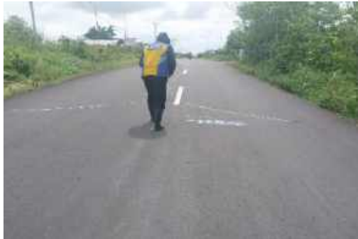
Rekonstruksi/ Peningkatan Jalan Mokmer – Parai -Biak kota
