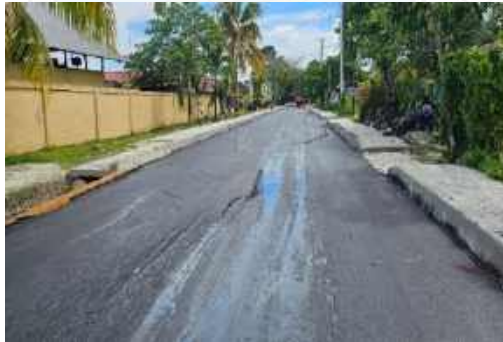
Rekontruksi/ Peningkatan Jalan Diponegoro – Distrik Biak Kota
