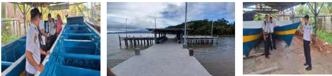
Gambar 3.59 Pembangunan Pelabuhan Pengumpan Lokal (Pembangunan Dermaga Mini di Napdori Distrik Swandiwe)
