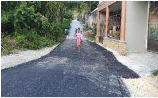
Rekontruksi/ Peningkatan Jalan Yenures Pantai – Distrk Biak Kota
