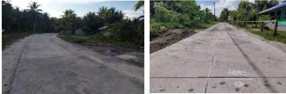
Gambar 3.52 Pembangunan dan Peningkatan Jalan Desa Strategis Ruas Jalan Pasi-Samber Pasi, Distrik Aimando
